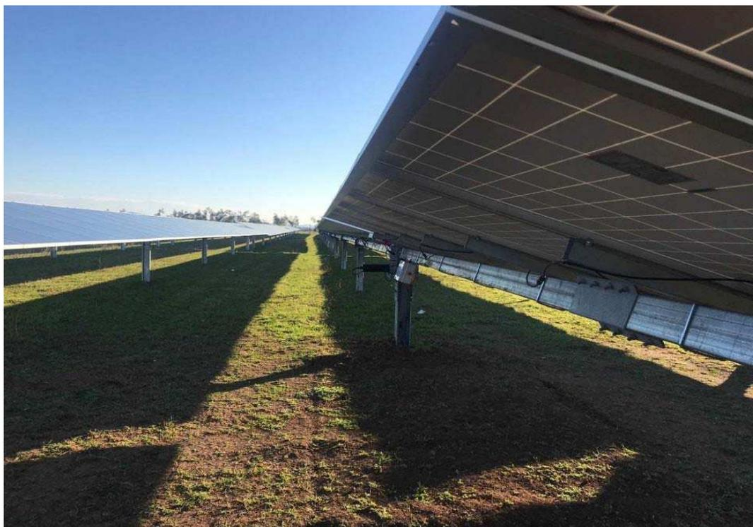
FIGURA 1 – INSTALLAZIONE DEL TRACKER
