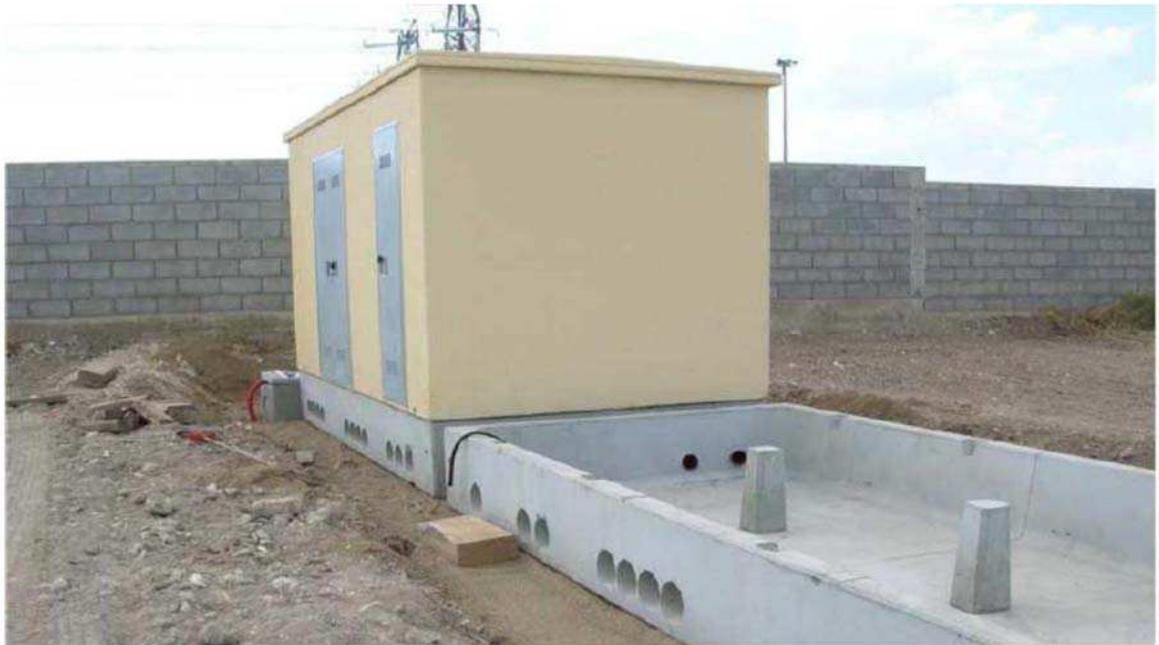
Le pareti esterne, dovranno essere trattate con un rivestimento murale plastico idrorepellente costituito da resine sintetiche pregiate, polvere di quarzo, ossidi coloranti ed additivi che garantiscono il perfetto ancoraggio sul manufatto, inalterabilità del colore e stabilità agli sbalzi di temperatura.
