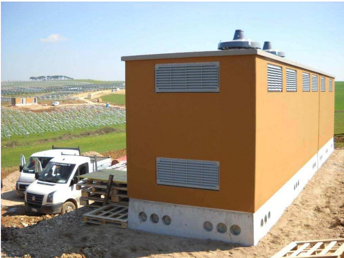
Le pareti esterne, dovranno essere trattate con un rivestimento murale plastico idrorepellente costituito da resine sintetiche pregiate, polvere di quarzo, ossidi coloranti ed additivi che garantiscono il perfetto ancoraggio sul manufatto, inalterabilità del colore e stabilità agli sbalzi di temperatura.
